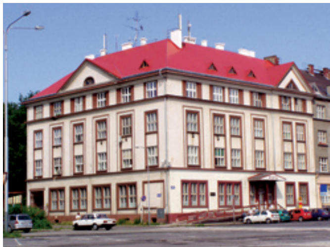
Šalounova 18 – stav po opravě Dodavatel: VAMOZ – servis a.s. Ostrava - Vítkovice
