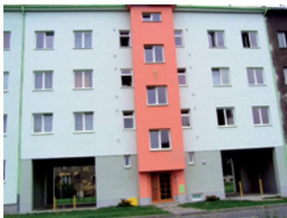
Syllabova 29 – stav po opravě Dodavatel: EKOFAS s.r.o. Ostrava – Vítkovice
