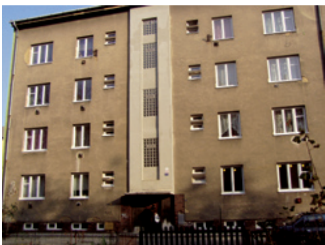
Dehtova 7 - po výměně
