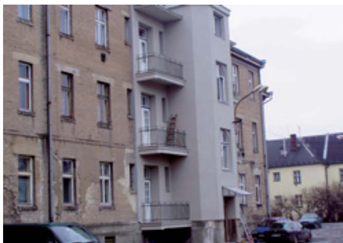
Rudná 38, 40 - stav po opravě Dodavatel: EKOFAS s.r.o. Ostrava – Vítkovice
