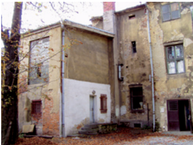
Jeremenkova 13 – původní stav
