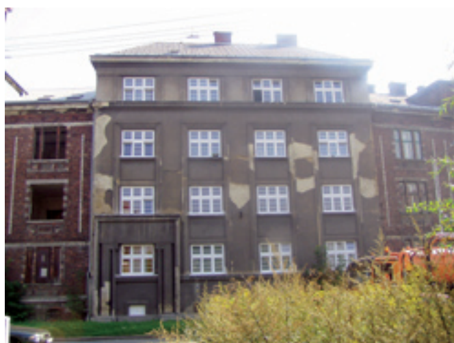
Štramberská 8 - po výměně
