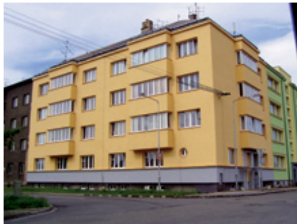
U Cementárny 29 – stav po investici Dodavatel: ESA building s.r.o. Ostrava – Mariánské Hory
