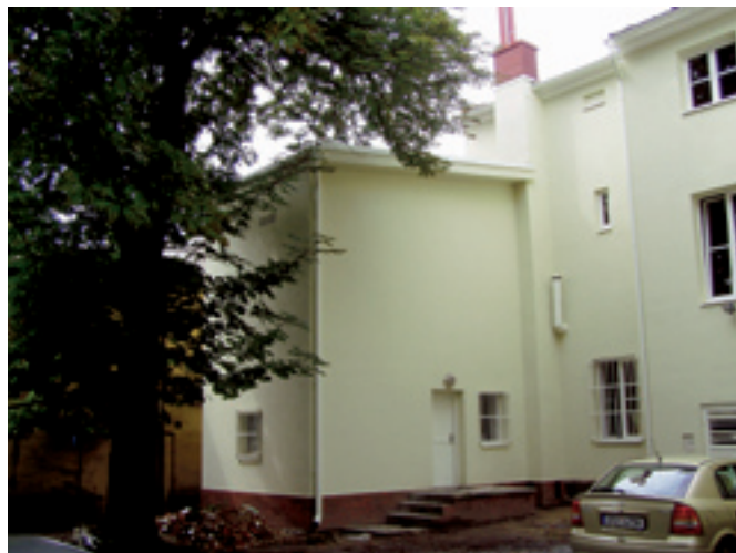
Jeremenkova 13 – stav po opravě
