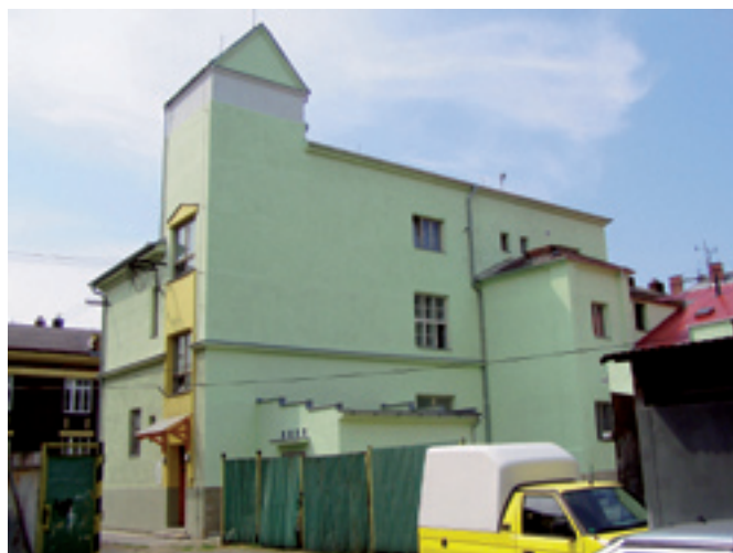
Zengrova 14 - stav po opravě
