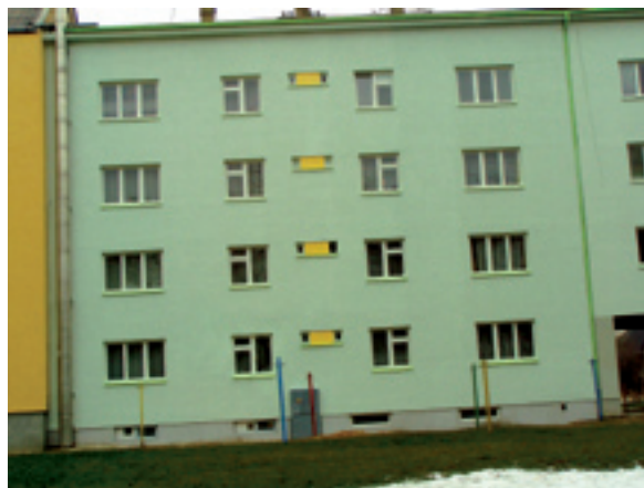
Syllabova 31 – stav po opravě Dodavatel: KAVIS s.r.o. Ostrava – Moravská Ostrava a Přívoz
