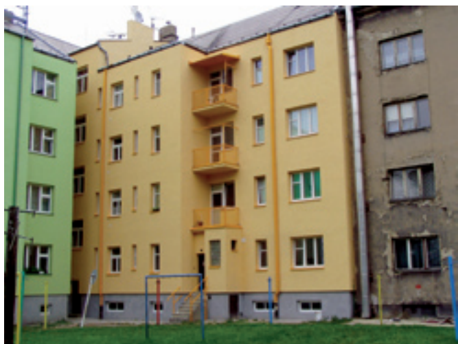
U Cementárny 29 – stav po opravě Dodavatel: ESA building s.r.o. Ostrava - Mariánské Hory
