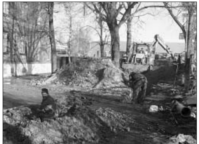
Ve středu v poledne pracovali i s bagristou na plynové přípojce do haly Mercedes Moravia tři dělníci. V pozadí je hala, vedle ní těžní věž bývalého Dolu Jeremenko.
