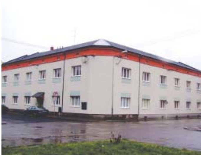
Nerudova 27 - stav po rekonstrukci
