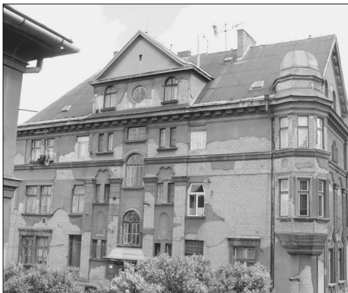
Před opravou fasády.
