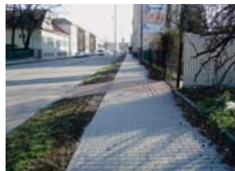
Oprava chodníku v ul. Lidické
