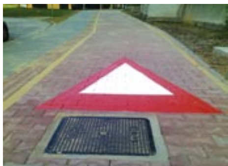
Rekonstrukce cykl. stezky Na Obvodu
