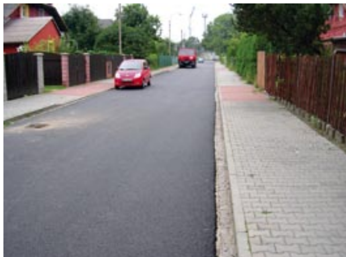
Oprava vozovky v ul. Kovářské
