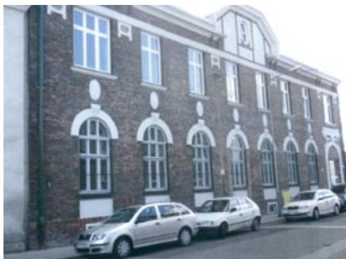
oprava štukových částí přední fasády
