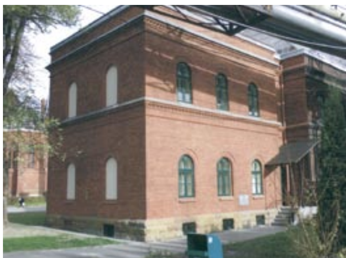
výměna oken, čistění fasády
