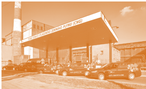
Plnicí stanice na CNG v Ruské ulici.
