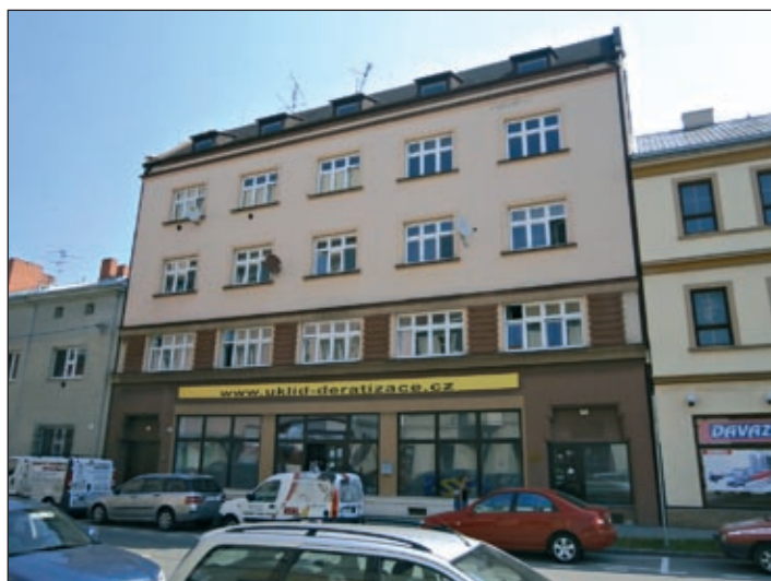
Zateplení štítu domu v ulici Lidické 27.
