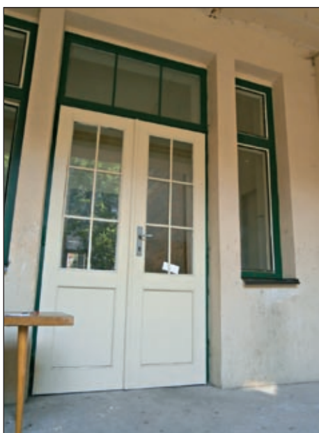
Okna bývají nazývána očima domu. Po opravě a nátěru oken dům v Sirotcí 43 „prokoukl“.
