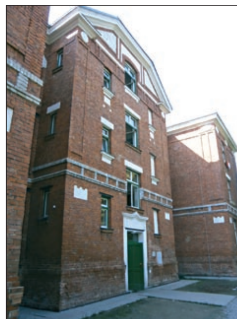
Díky programu IPRM proběhla rozsáhlá rekonstrukce domu v Sirotcí 74.
