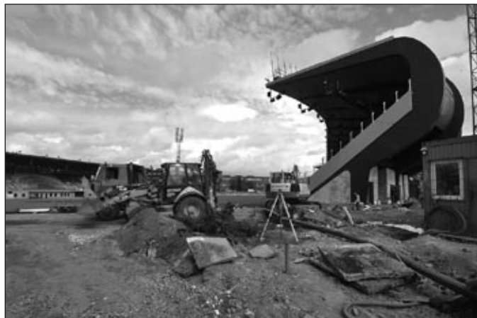
Takto vypadal stadion necelé tři týdny před ukončením první etapy rekonstrukce.
