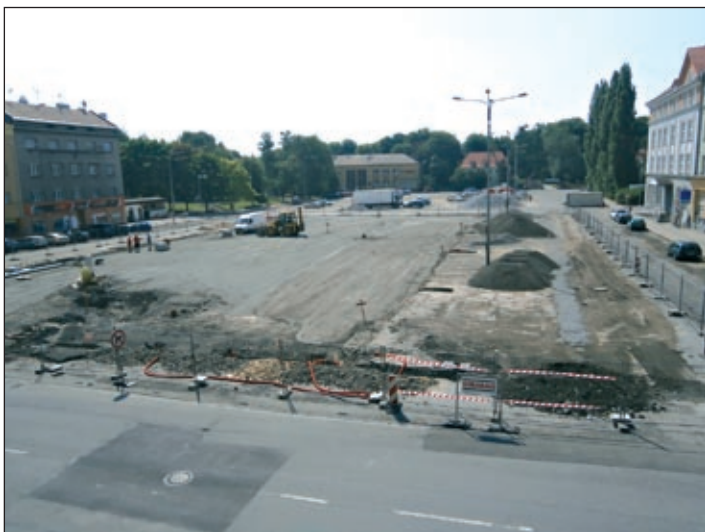
Právě probíhající rekonstrukce náměstí Jiřího z Poděbrad...
