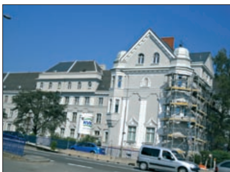
Pokračuje oprava fasády domu Rudná 38.
