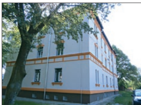
Zateplení rozzářilo dům v Ocelářské 45.
