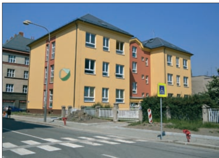
Rekonstrukci budovy ZŠ Halasova jsme v loňském roce věnovali velkou pozornost.
