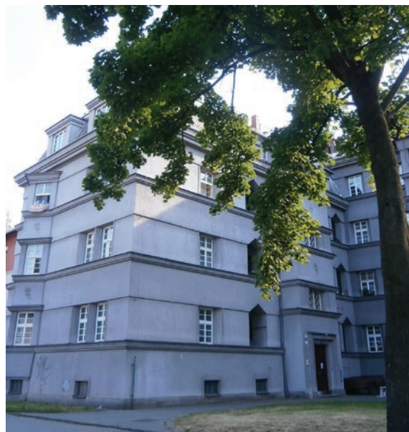
V období následujících tří měsíců bude provedena výměna oken v ulici Ruské 37, 37A a 39.
