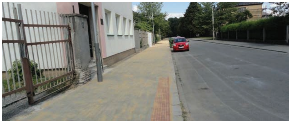
Syllabova po opravě
