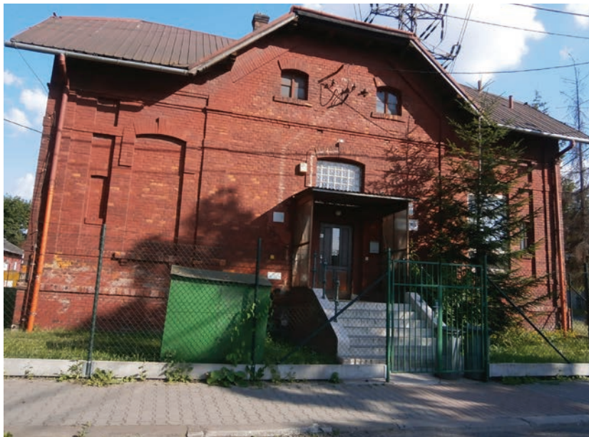
Probíhají stavební úpravy MŠ Obránců míru. Rekonstruovány budou komíny, půda, okna, podhledy v interiéru i fasáda.
