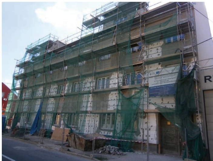
Finišuje rekonstrukce domů Štramberská 29, 29A, a to díky programu IPRM.
