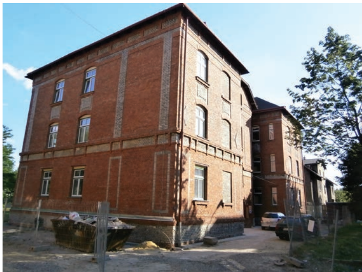
Rekonstrukce domu Siroťčí 43A, financována z programu IPRM, je v plném proudu.
