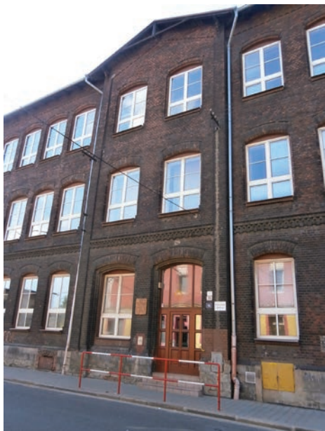
V srpnu roku 2013 byla dokončena úprava vytápění v ZŠ Šalounova.
