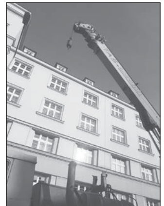
Rekonstrukce v ulici Štramberské.
