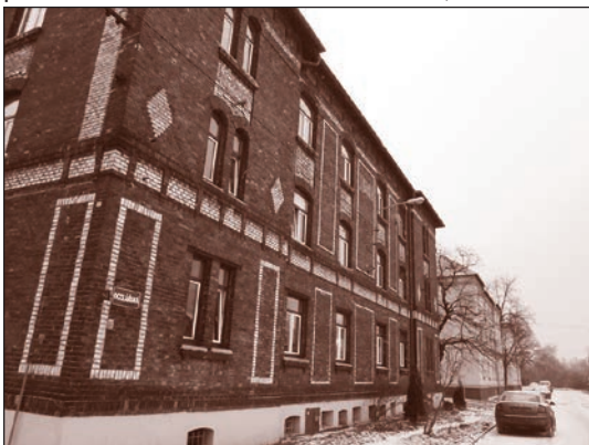
Rozpočet obvodu počítá s investicí do zateplení domu v Ocelářské 43.
