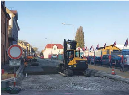
V polovině října byly práce na rozšíření vjezdu do ulice U Cementárny v plném proudu.
