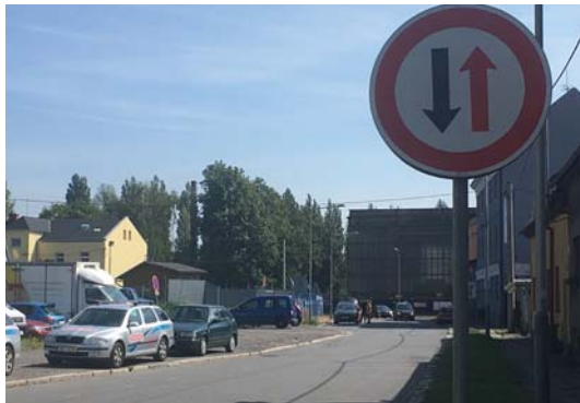
Zúžení komunikace na rohu ulic Štramberská a U Cementárny bude brzy minulostí. Stavba byla zahájena 21. srpna.
