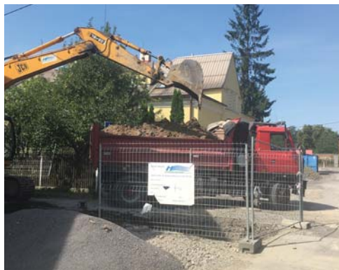
V srpnu byla zahájena oprava povrchu v Pas-teurově ulici.
