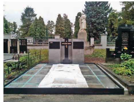
Hrobka během úprav.
