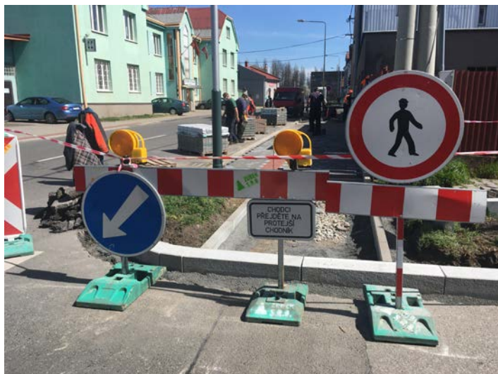
Oprava části chodníku podél ulice U Cementárny
