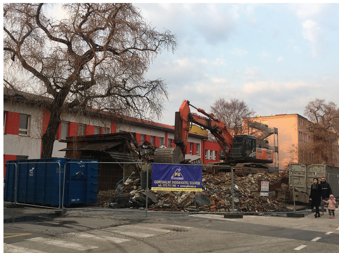
... a po demolicí.
