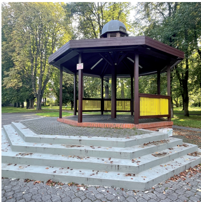
V sadu Jožky Jabůrkové byl natřen altán a opraveno schodiště.
