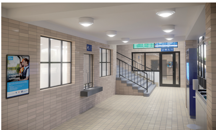
Rekonstrukce vítkovického vlakového nádraží už probíhá.
