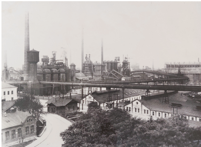
Celkový pohled na vysoké pece z roku 1926.
